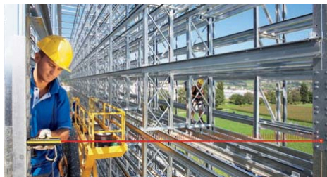
Menuiserie métallique – Mesure de grandes distances grâce au localisateur numérique
